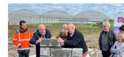
Pose de la première pierre du tiers-lieu alimentaire et nourricier du Jardin de Cocagne du Raquet (Hauts-de-France)
