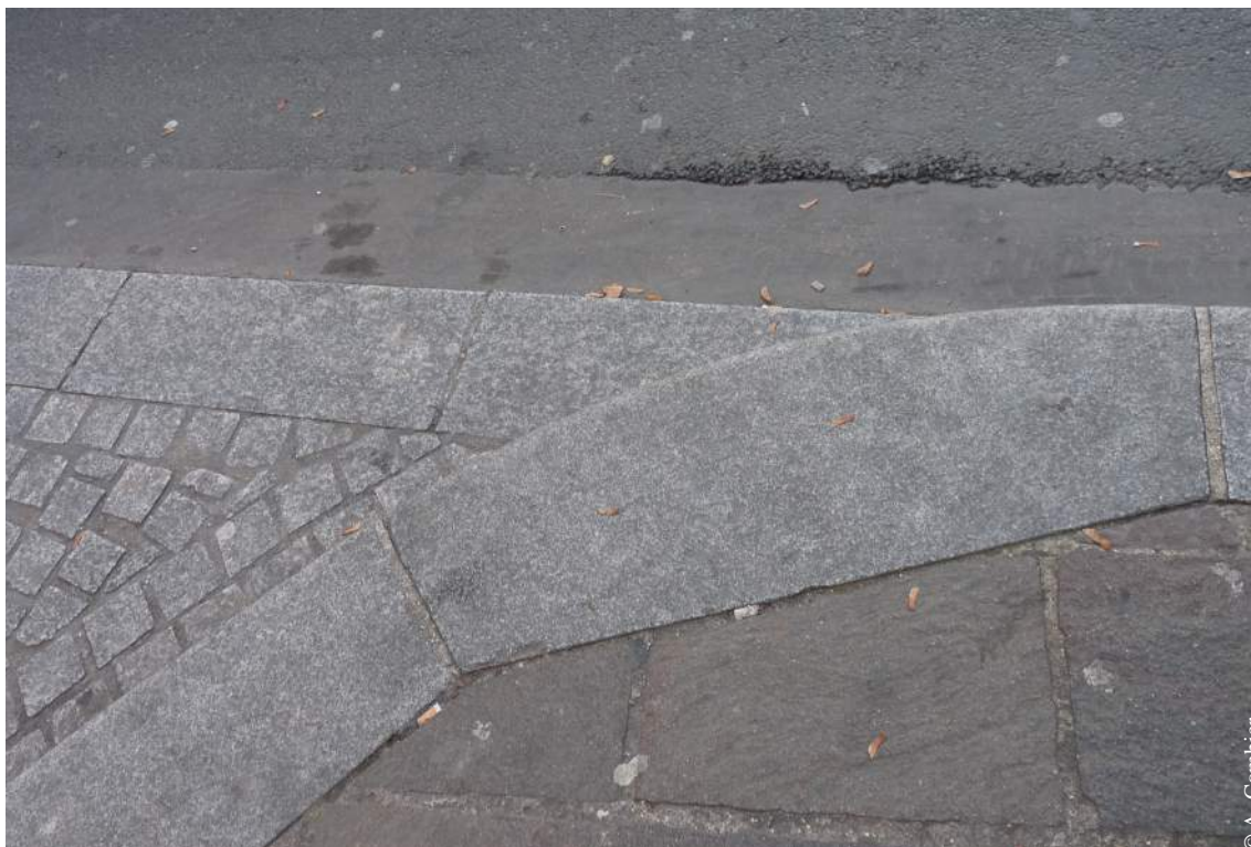
Utilisation de matériaux de sol variés à la jonction d’un trottoir, d’une rue piétonne et d’une avenue.
